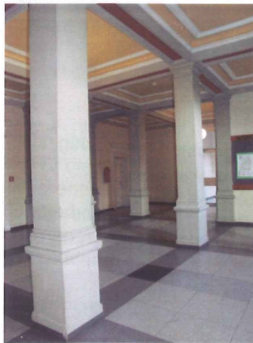
Flur im Mittelbau im 1. OG
